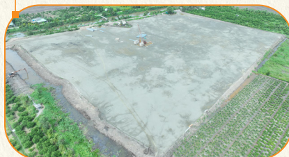
Nhà máy xử lý nước thải
