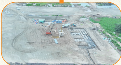
Nhà máy cấp nước
