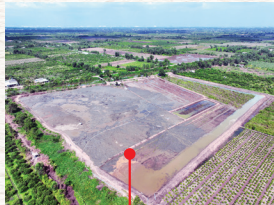
Nhà máy xử lý nước thải
