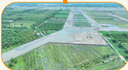
Nhà máy cấp nước Bơm cát (hoàn thành) Ép cọc (đang thực hiện)
