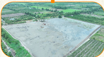
Nhà máy xử lý nước thải Bơm cát (hoàn thành) Ép cọc (đang thực hiện)
