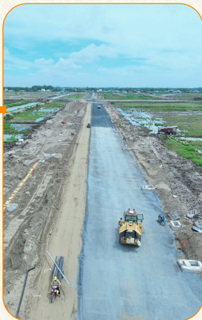
Đường DD3 Thi công lu lên nền đường (đang thực hiện)
